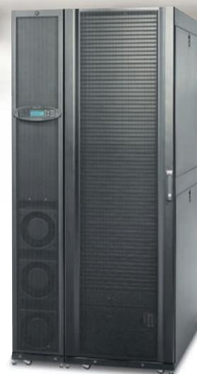
Стойчатые системы охлаждения APC забирают горячий воздух с тыльной стороны, в месте его образования, и затем предоставляют охлажденный воздух, готовый для использования в соседних стойках, с фронтальной стороны.
